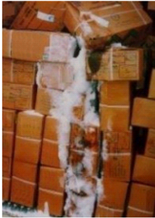
그림1.12 도어 가스켓 누수로 인한 결빙
